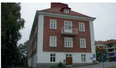
Koukkuniemen hallintorakennus, Tampere
