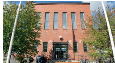
Tampereen Sähkölaitos, Tampere
