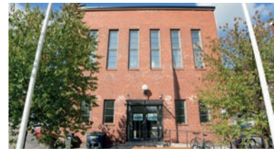
Tampereen Sähkölaitos, Tampere
