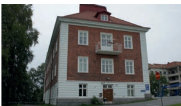
Koukkuniemen hallintorakennus, Tampere
